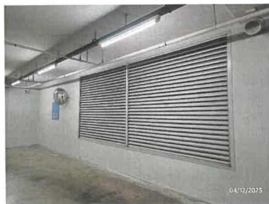
รูปที่ 4 พัฒนาระบายอากาศบริเวณชั้นใต้ดิน
