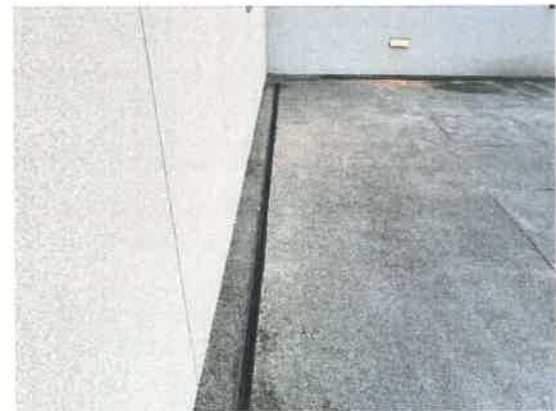
ท่อรวบรวมน้ำจากการล้างพื้นห้องพัสดุมูลฝอยรวม
