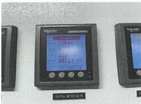
รูปที่ 13 มิเตอร์ไฟฟ้าสำหรับระบบบำบัดน้ำเสีย
