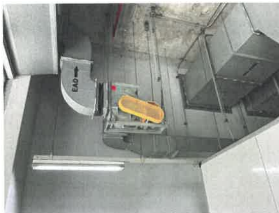
รูปที่ 9 พัดลมระบายอากาศจากชั้นจอดรถออกสู่บริเวณชั้นที่ 7 ด้านทิศเหนือ
